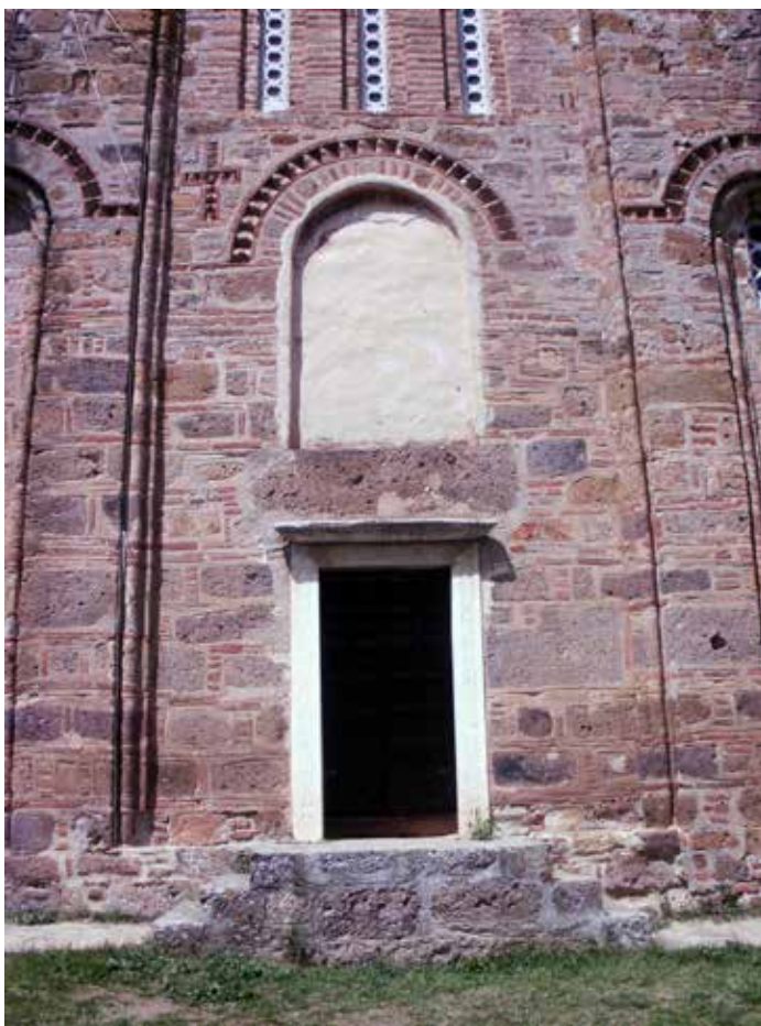
Sl. 1 Lesново, црква Архистратига Михаила, централни део јужне фасаде наоса (1340/1341)
