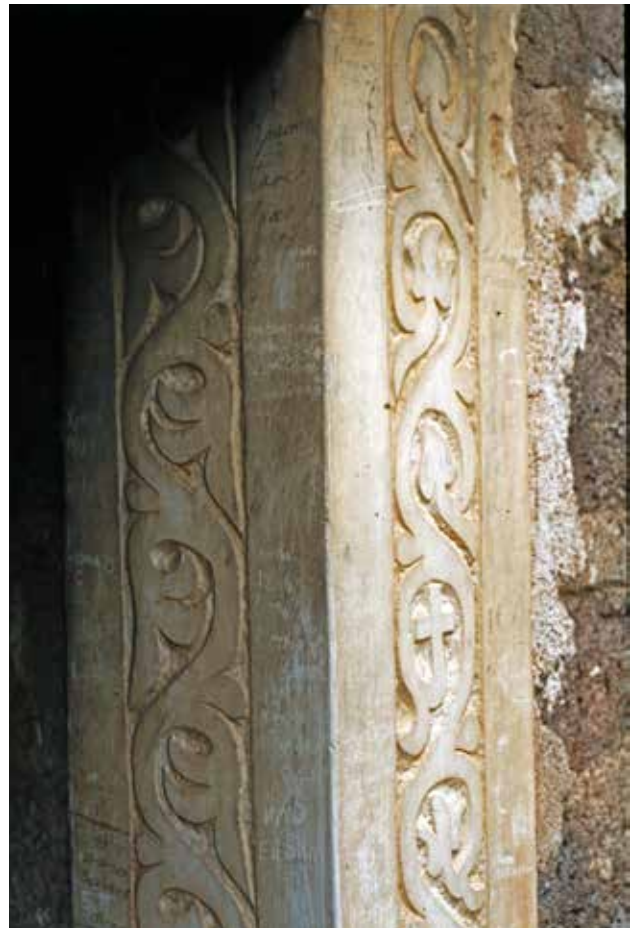
Sl. 3 Južni portal, detalj
